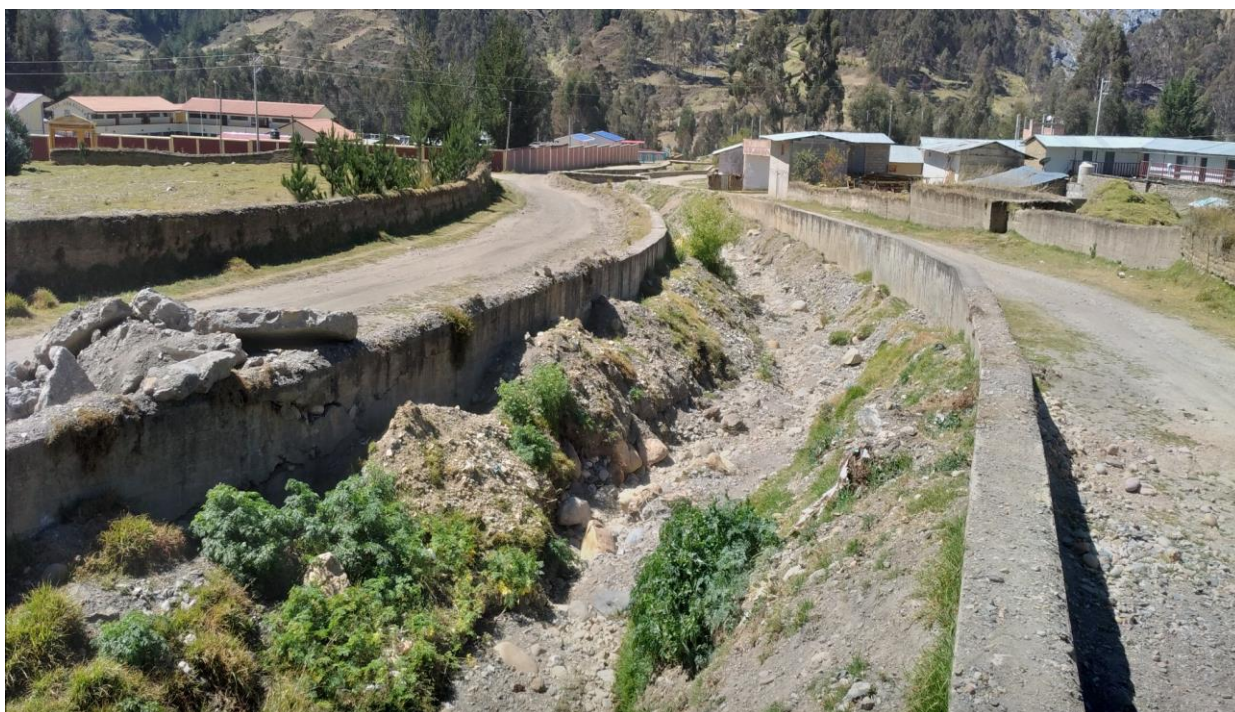
FIGURA N° 1 LOS MUROS DE PROTECCIÓN DE LA Qda. CHEGCHILLHUAN SE VEN AFECTADOS POR LA LA EROSIÓN CONTINUA
