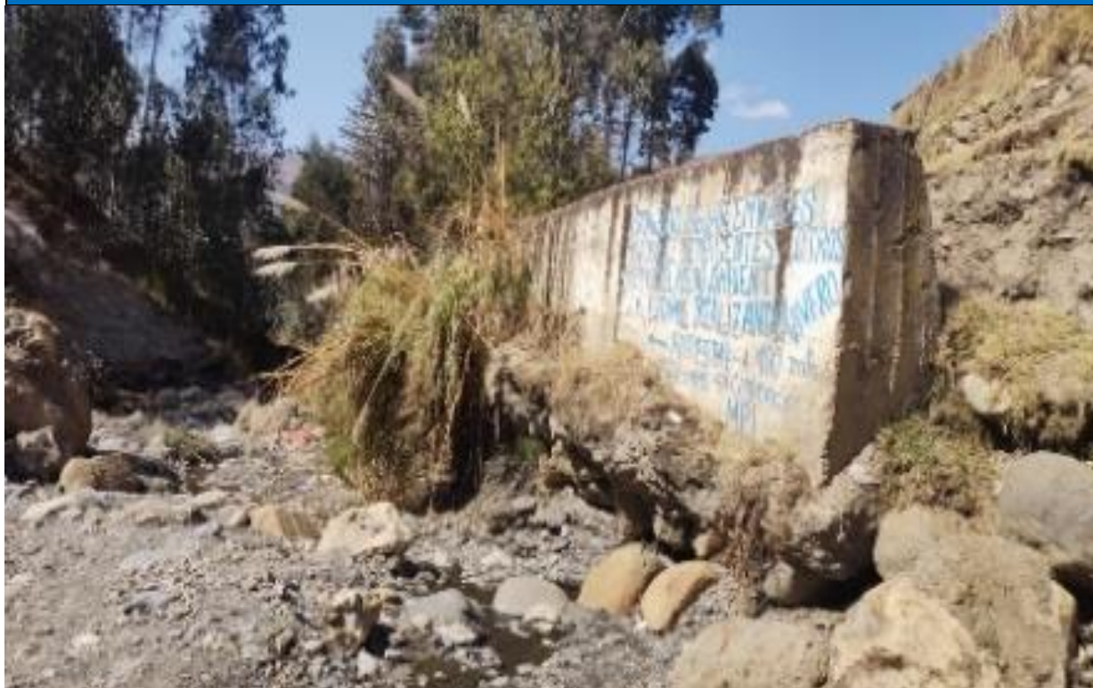
FIGURA N° 1 LOS MUROS DE PROTECCIÓN DE LA Qda. CHEGCHILLHUAN SE VEN AFECTADOS POR LA LA EROSIÓN CONTINUA
